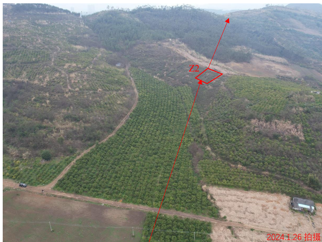
Z2 铁塔现状
