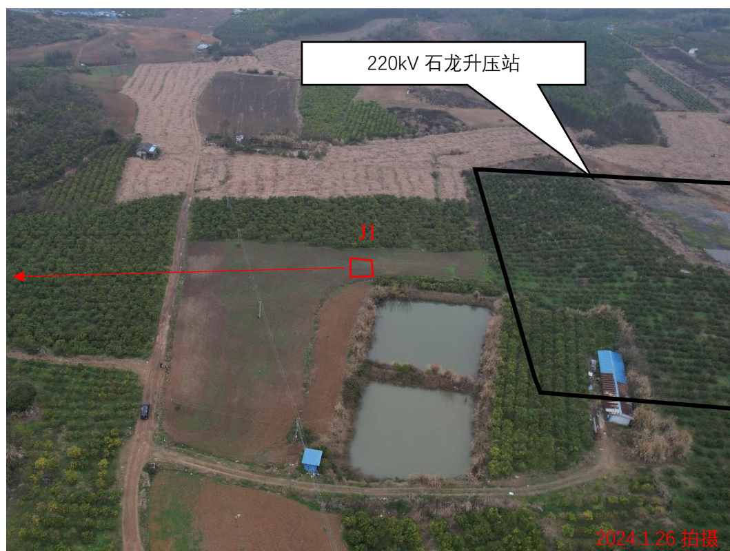
路径起点现状（220kV 石龙升压站）
