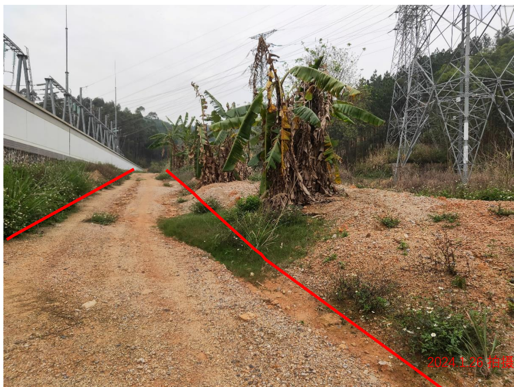
间隔扩建区处施工便道区现状图 1
