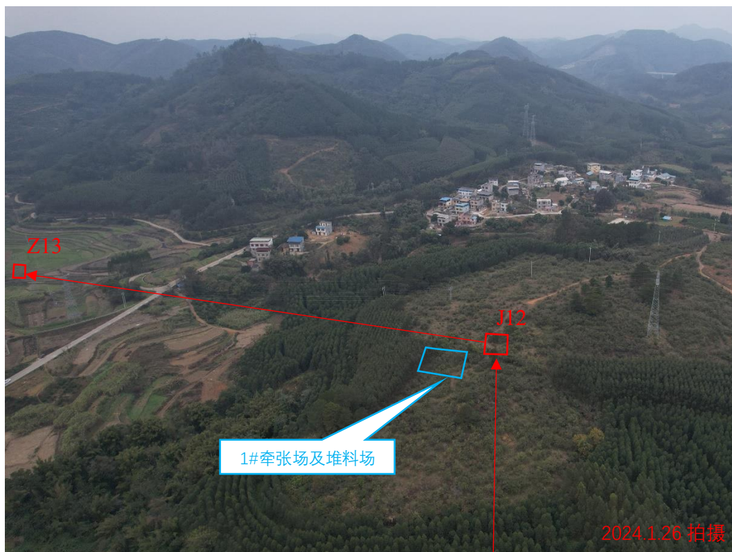
J12、Z13、1#牵张场及堆料场现状
