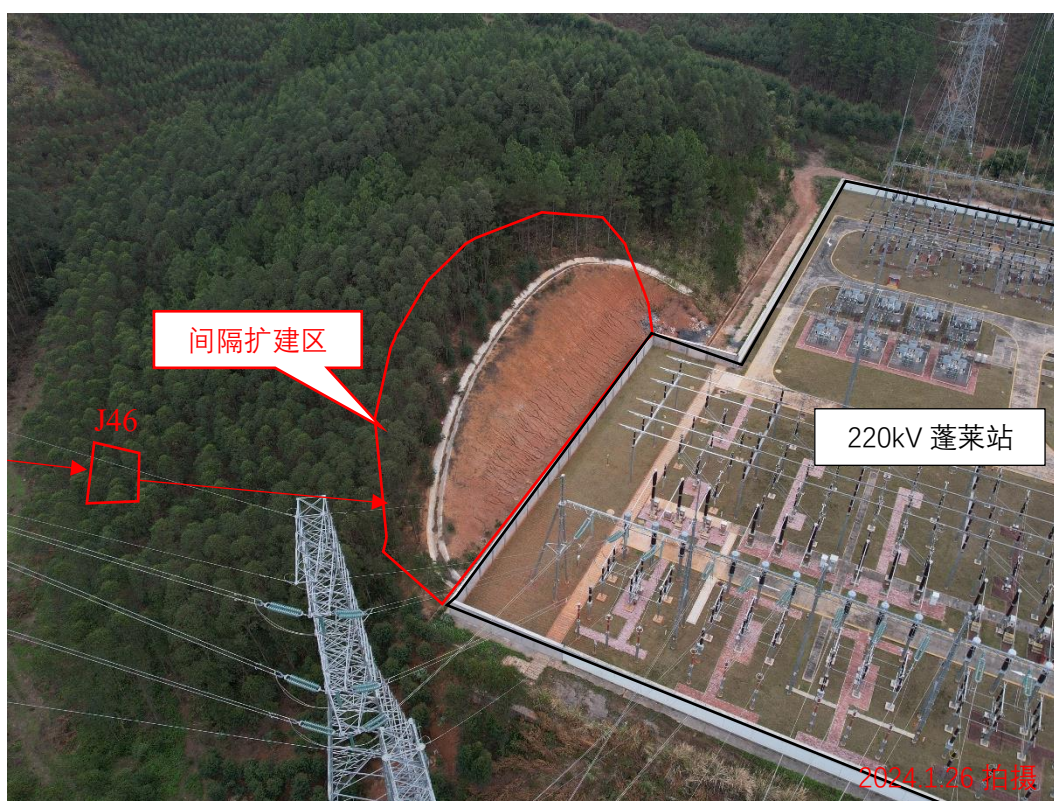
间隔扩建区现状（220kV 蓬莱站）
