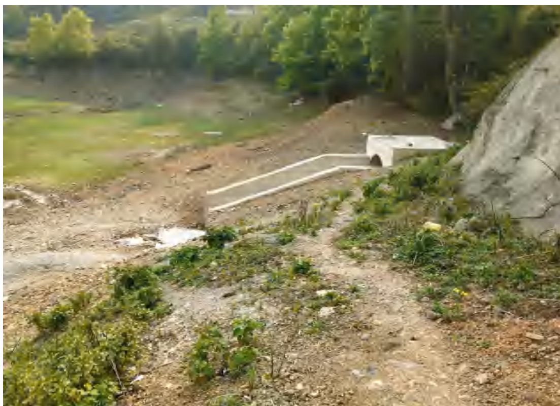
施工后的输水隧洞（2018 年 8 月 30 日）
