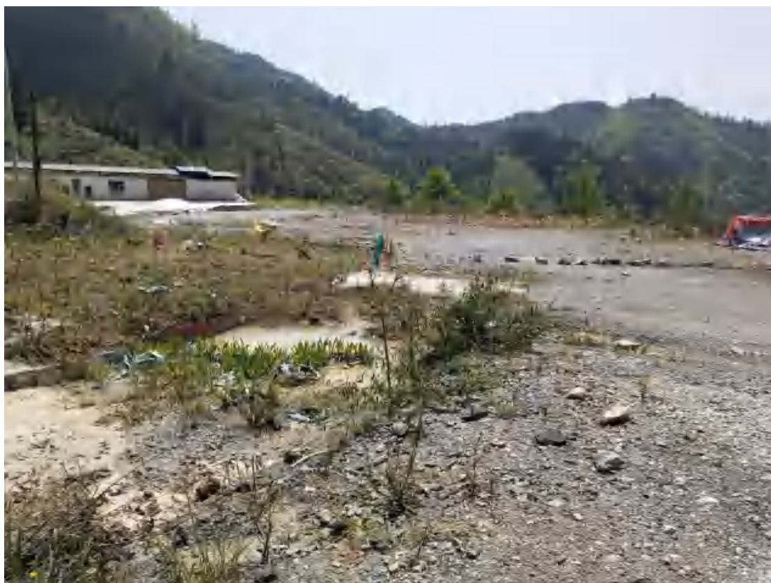
坝区施工生产区（2018 年 8 月 10 日）
