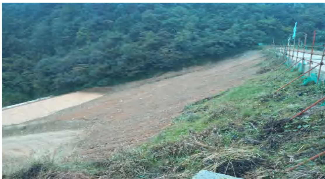
坝体施工（2017 年 3 月 5 日）
