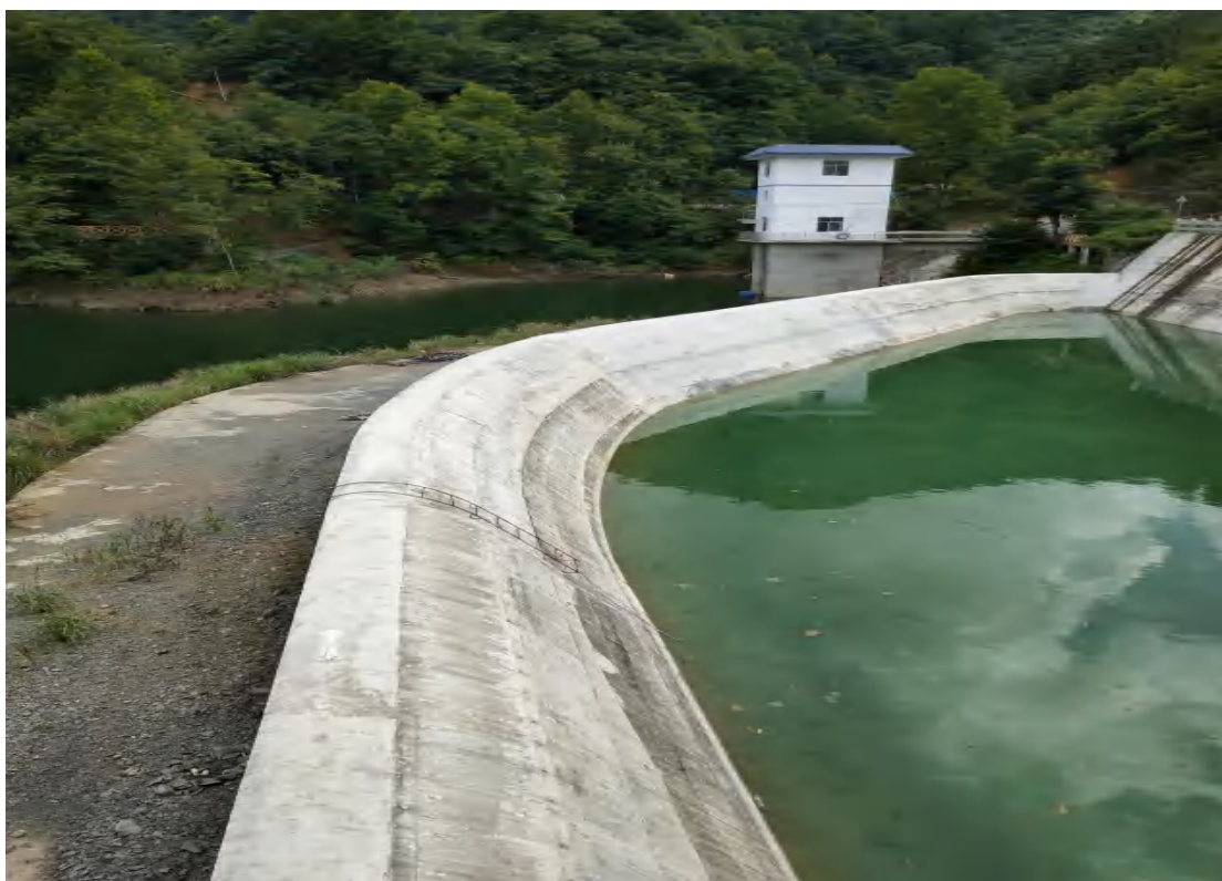
自然恢复期溢洪道、放水塔、施工道路（2019 年 2 月 15 日）
