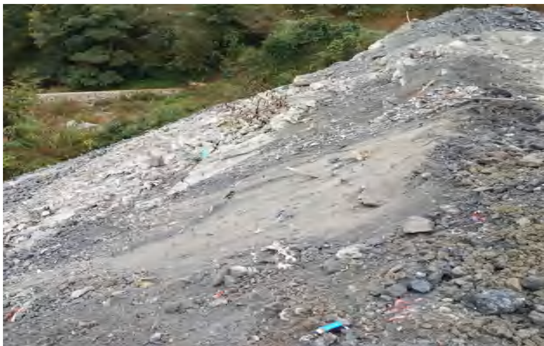
施工期的 2#弃渣场（2017 年 10 月 5 日）
