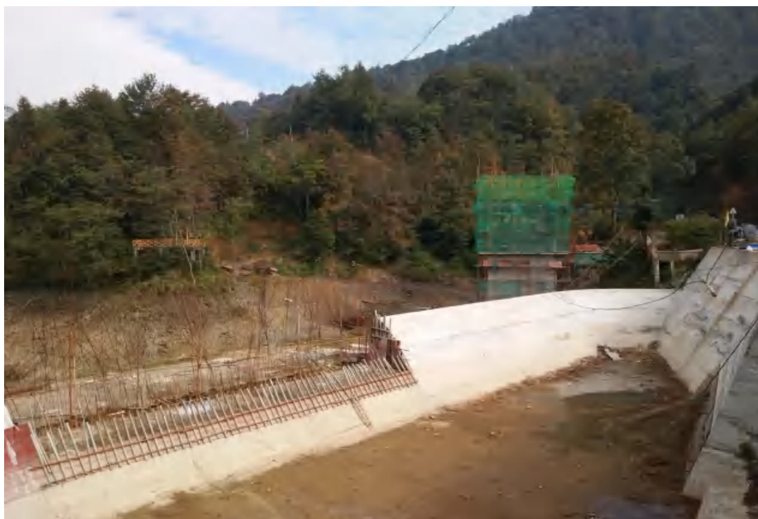
施工期溢洪道、放水塔、施工道路（2017 年 8 月 10 日）
