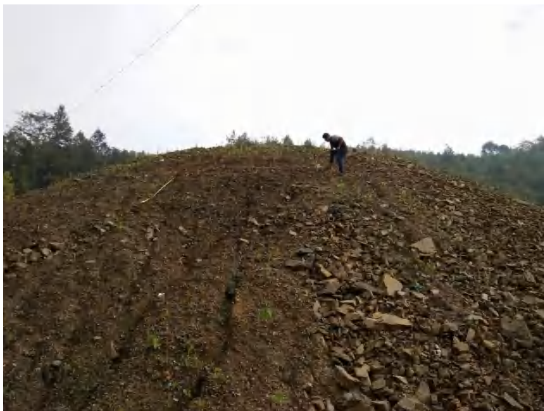
施工期的 1#弃渣场（2017 年 8 月 5 日）
