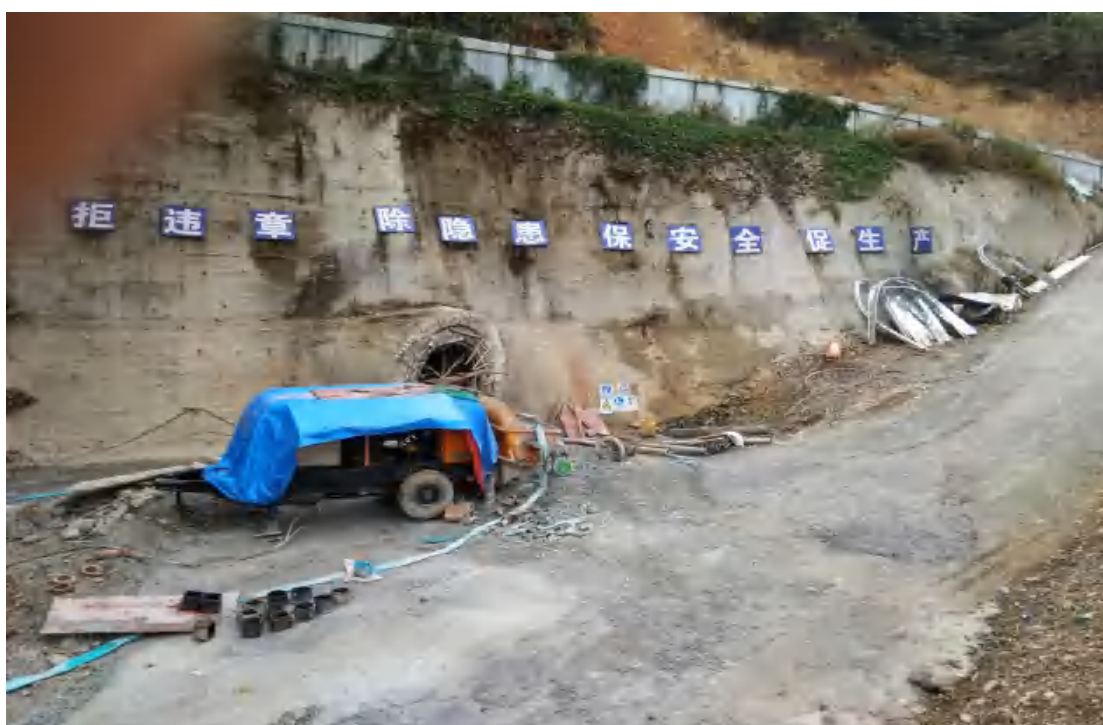
施工期的输水隧洞（2017 年 5 月 20 日）
