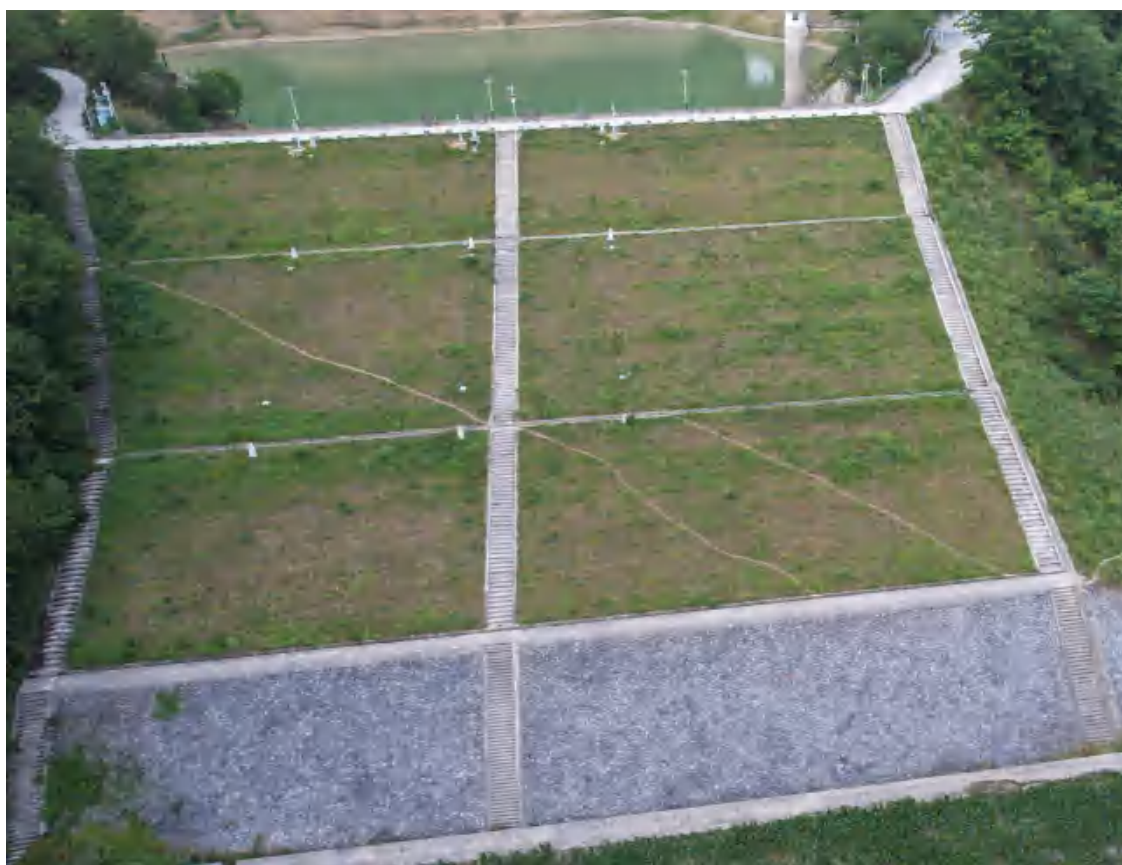
坝体施工完成（2019 年 7 月 12 日）
