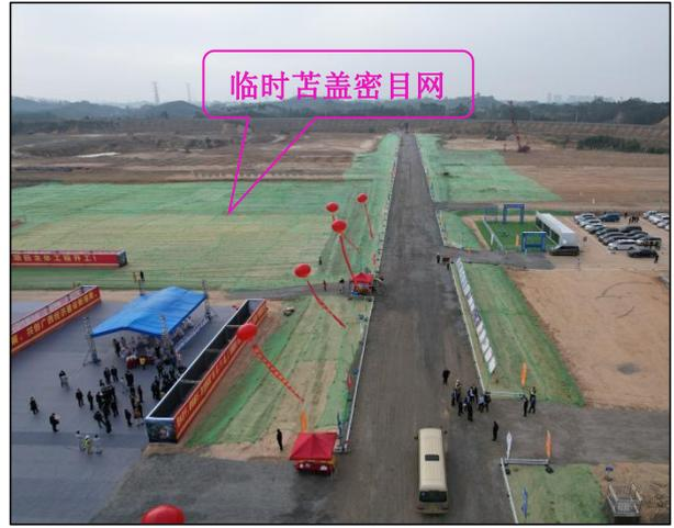
厂区建设区中部临时苫盖密目网现状图，施工对临时运输道路两侧裸露地面进行临时苫盖密目网，措施防护效果良好
