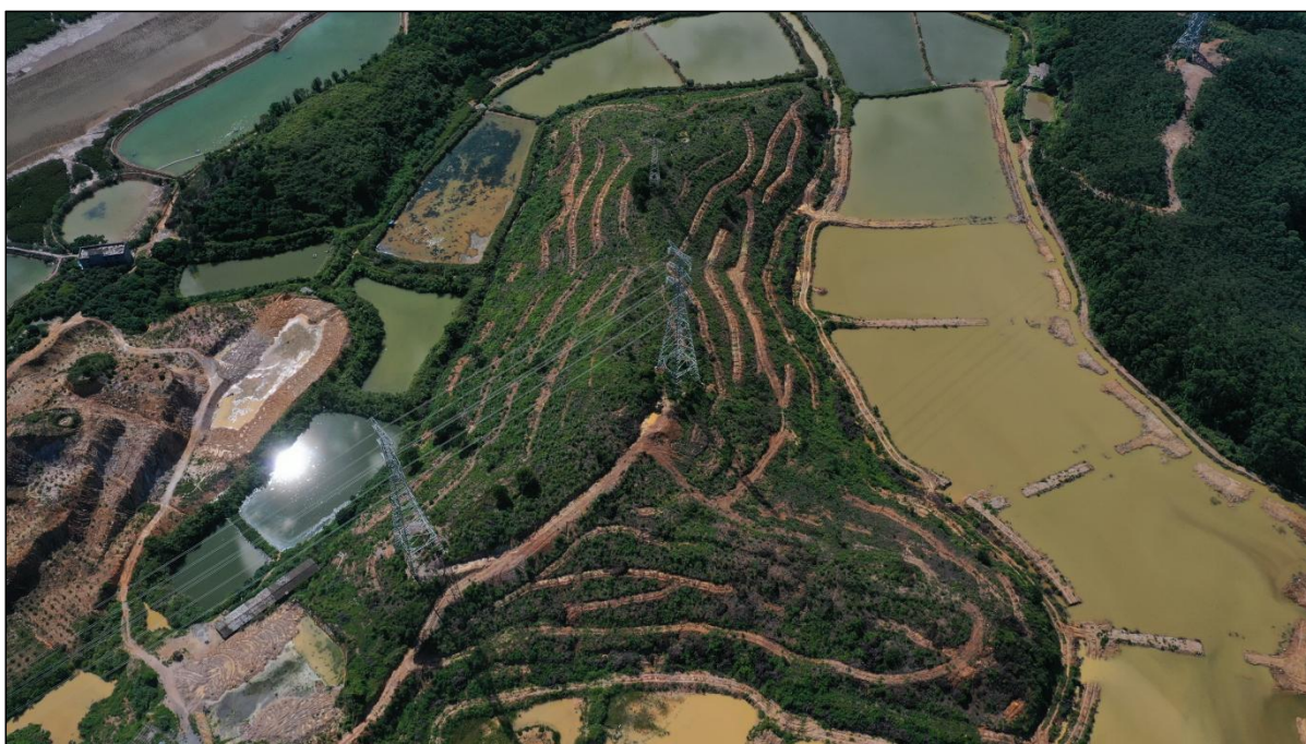
厂区建设区待建区用地东面现状图，未施工扰动的高压线塔现状呈现为地势起伏较大的土丘，现状无较大水土流失
