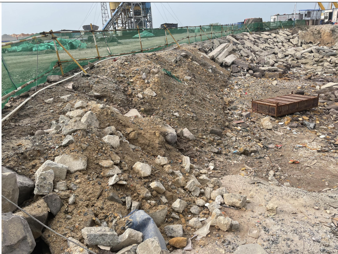
现状：主体工程已开工建设，靠近陆域部分有少量的临时堆土。 建议：建议对裸露的临时堆土补充临时覆盖措施。
