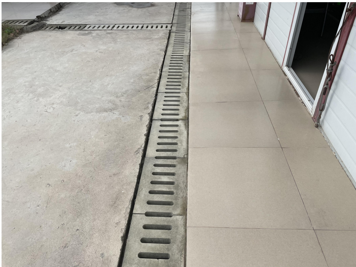
2#施工生活区采取的临时临时排水沟措施
