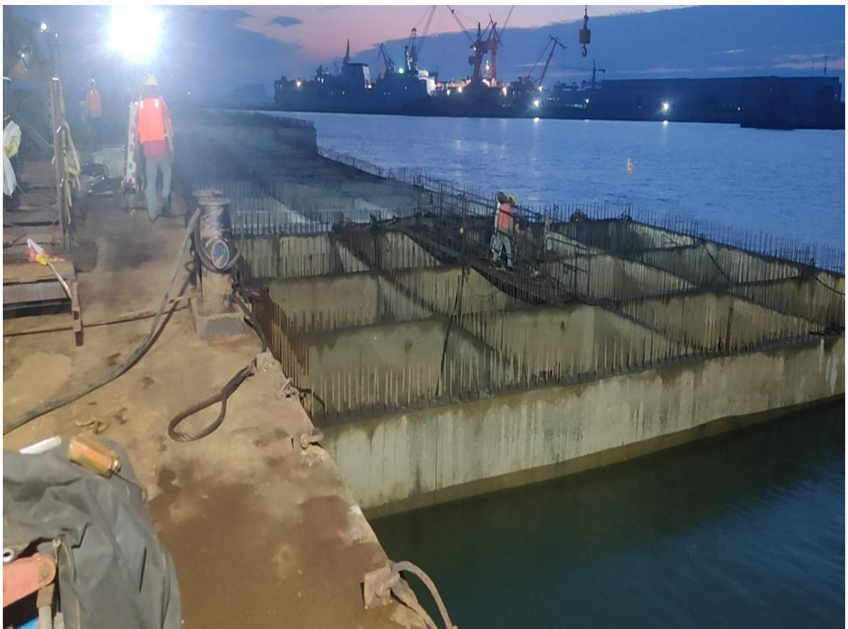
2#码头最后一件沉箱安装完成
