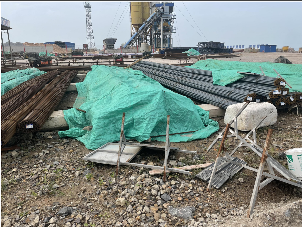
1#施工生产区施工材料采取的临时苫盖措施
