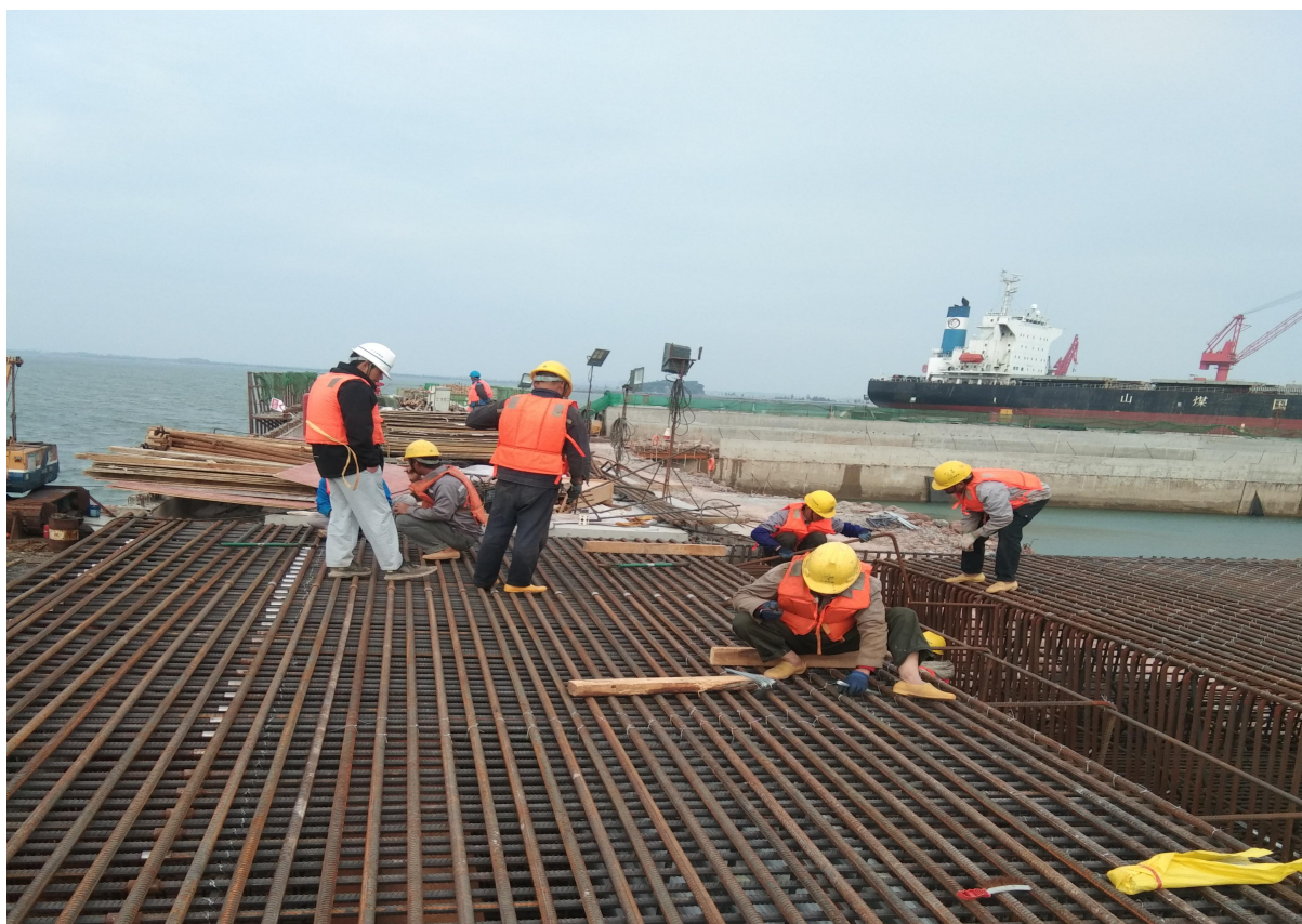
2-5 滑道钢筋绑扎
