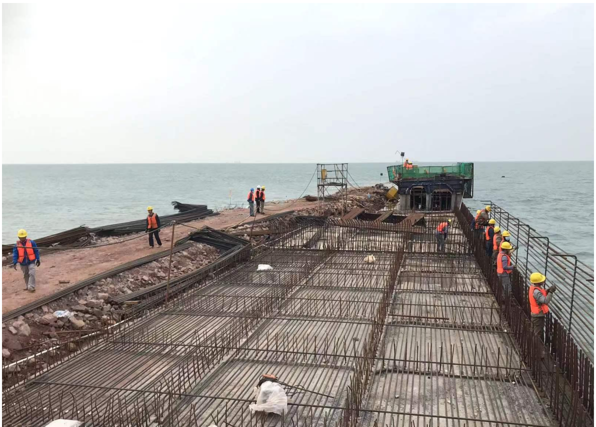
2-13 滑道钢筋绑扎
