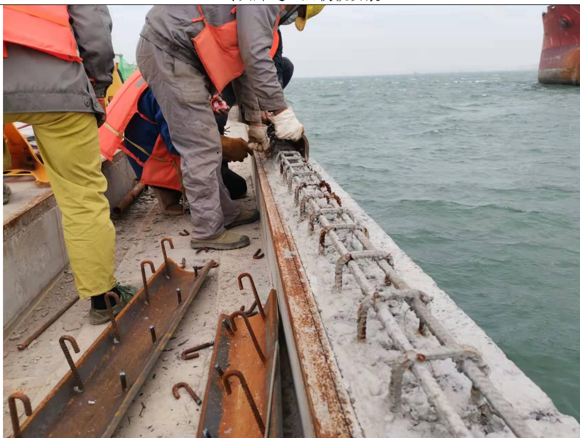
5#码头护轮坎护缘钢板安装
