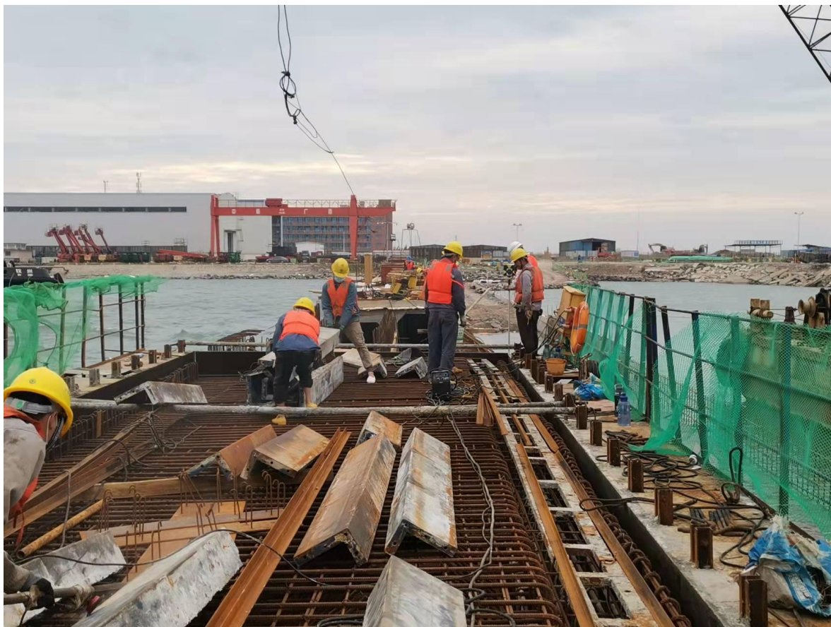
5#码头廊道二层模板安装
