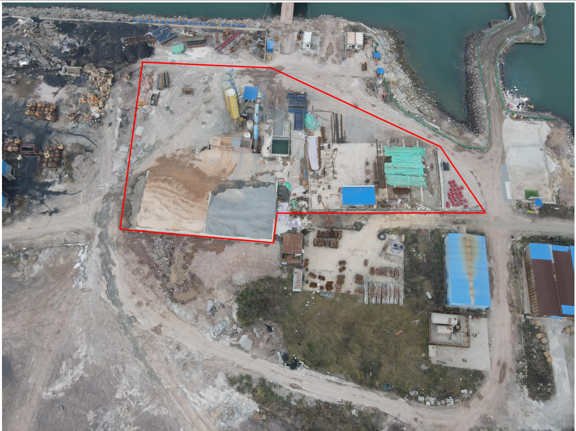
1#施工生产区航拍图（2021 年 12 月）
