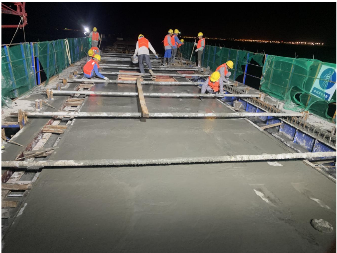
5#码头廊道顶层施工
