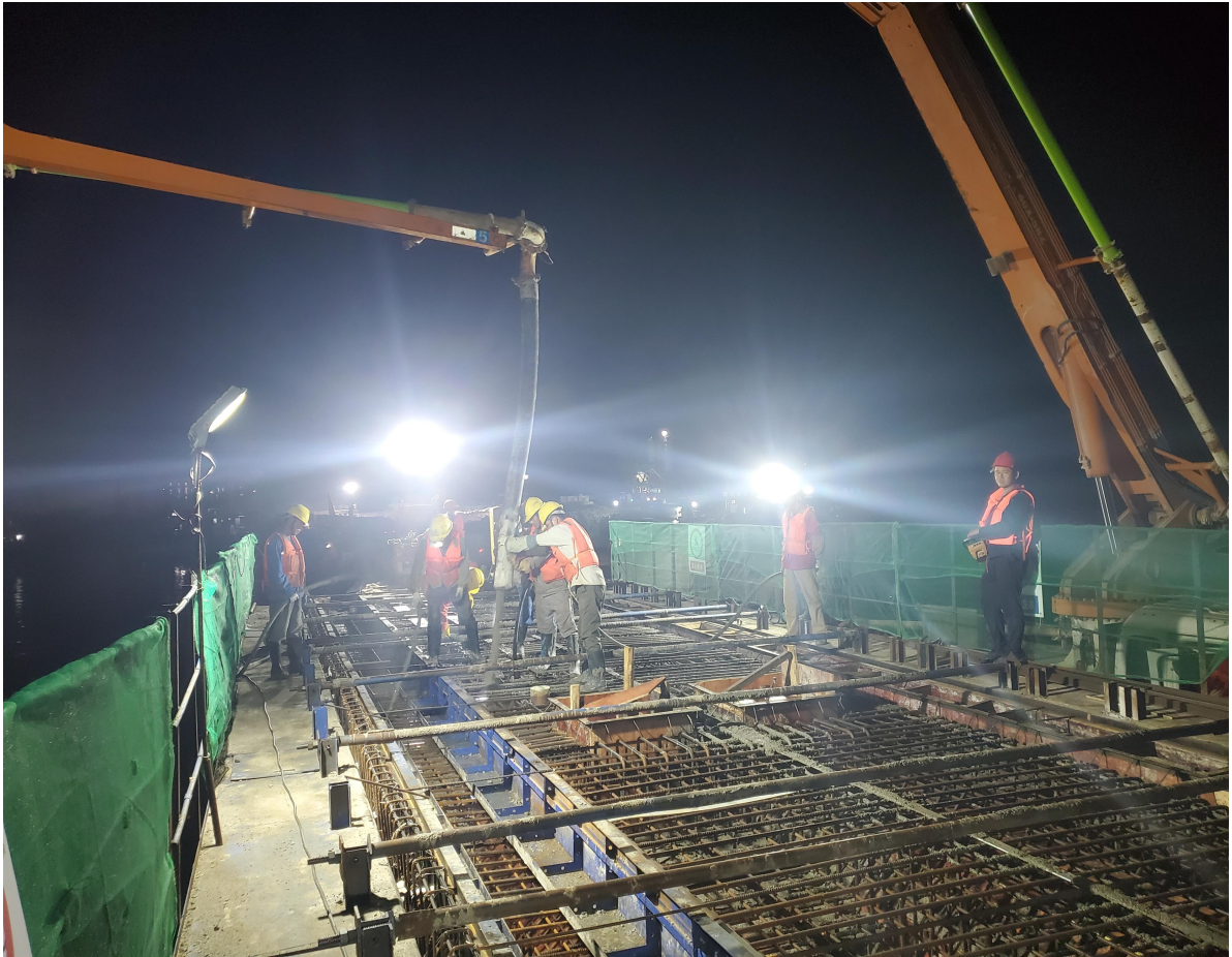
5#码头-14 廊道顶层施工
