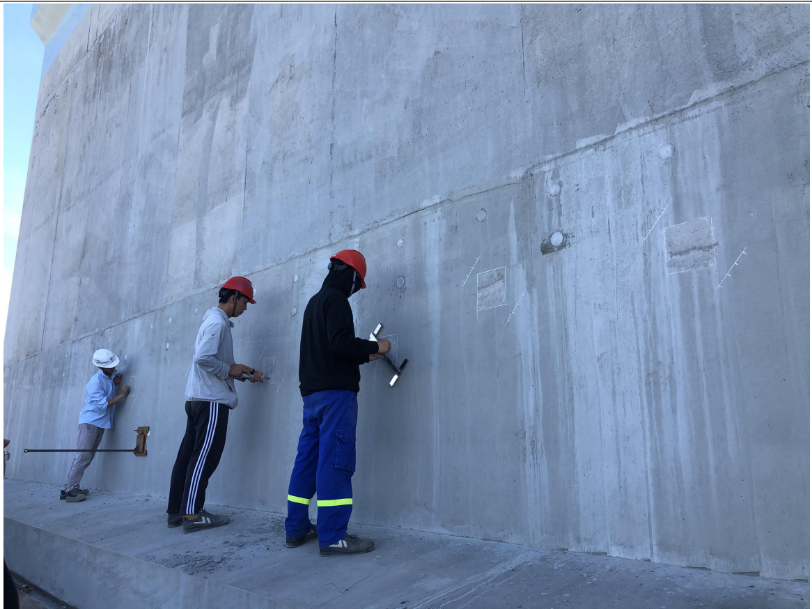
沉箱验证性检测
