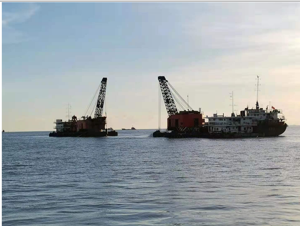
2#码头基槽凿岩、清礁施工
