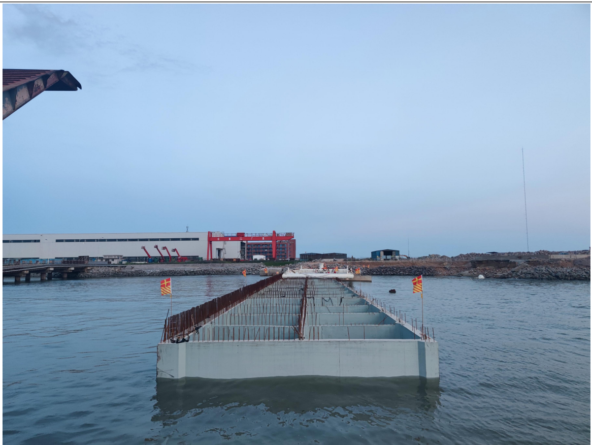
5#码头沉箱安装（累计7件）
