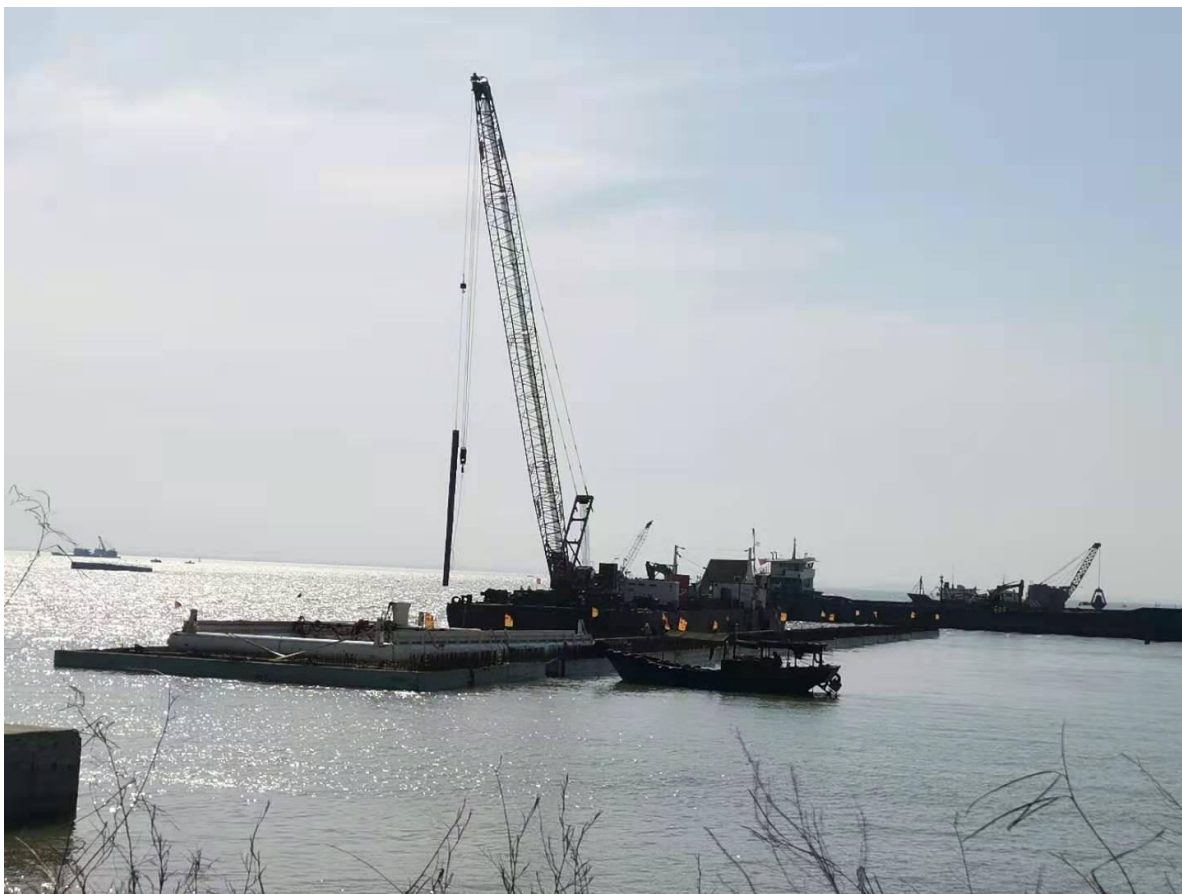
5#码头沉箱插板安装
