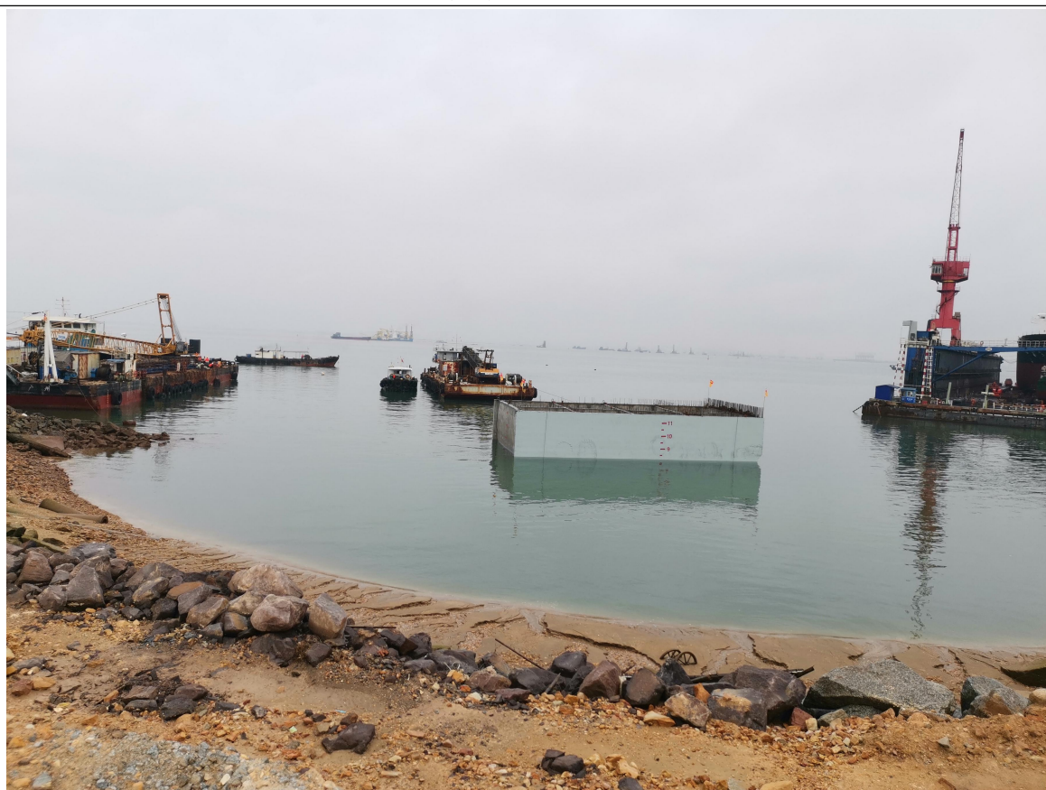
5#码头首件沉箱安装
