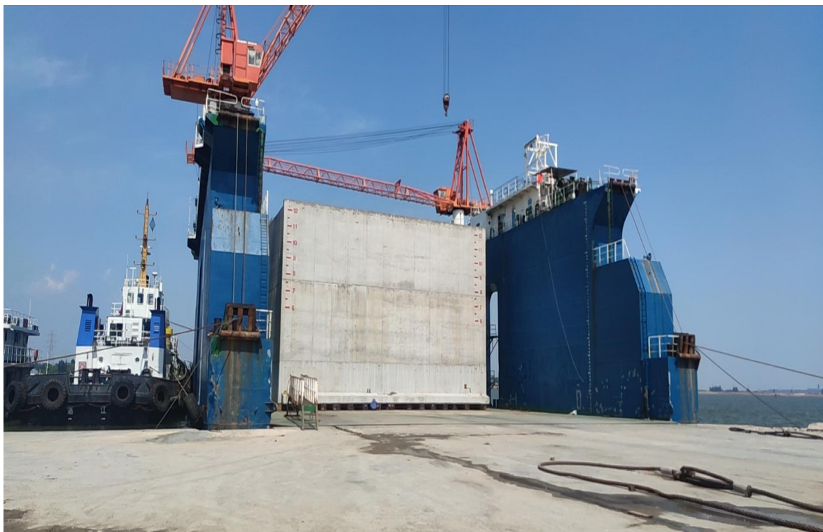
2#码头首件沉箱上驳
