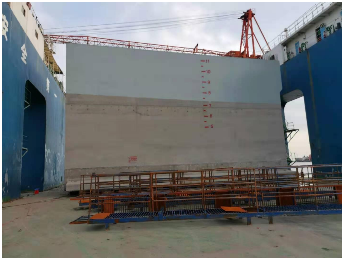
5#码头首件沉箱出运至现场
