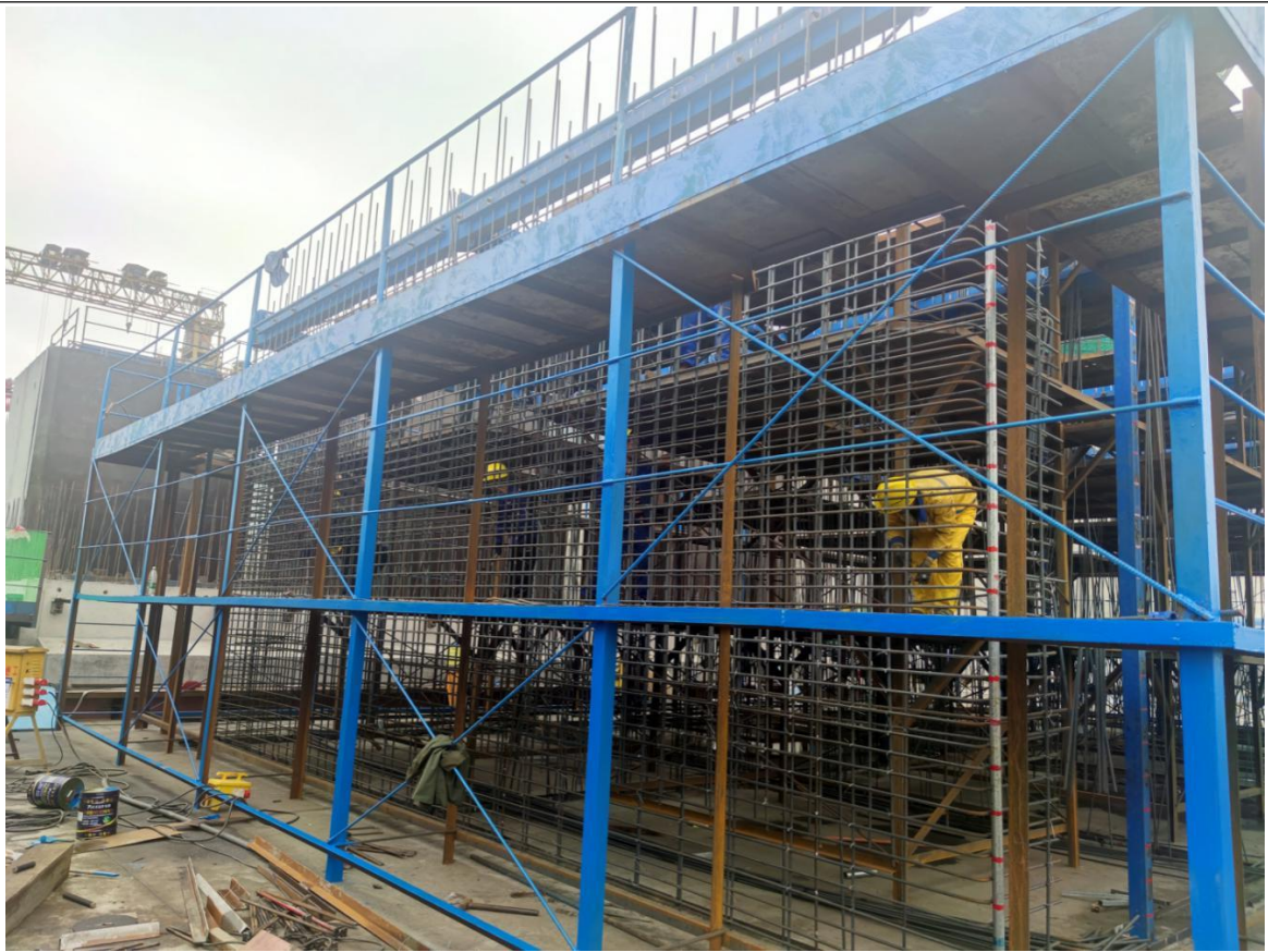
标准层沉箱钢筋绑扎
