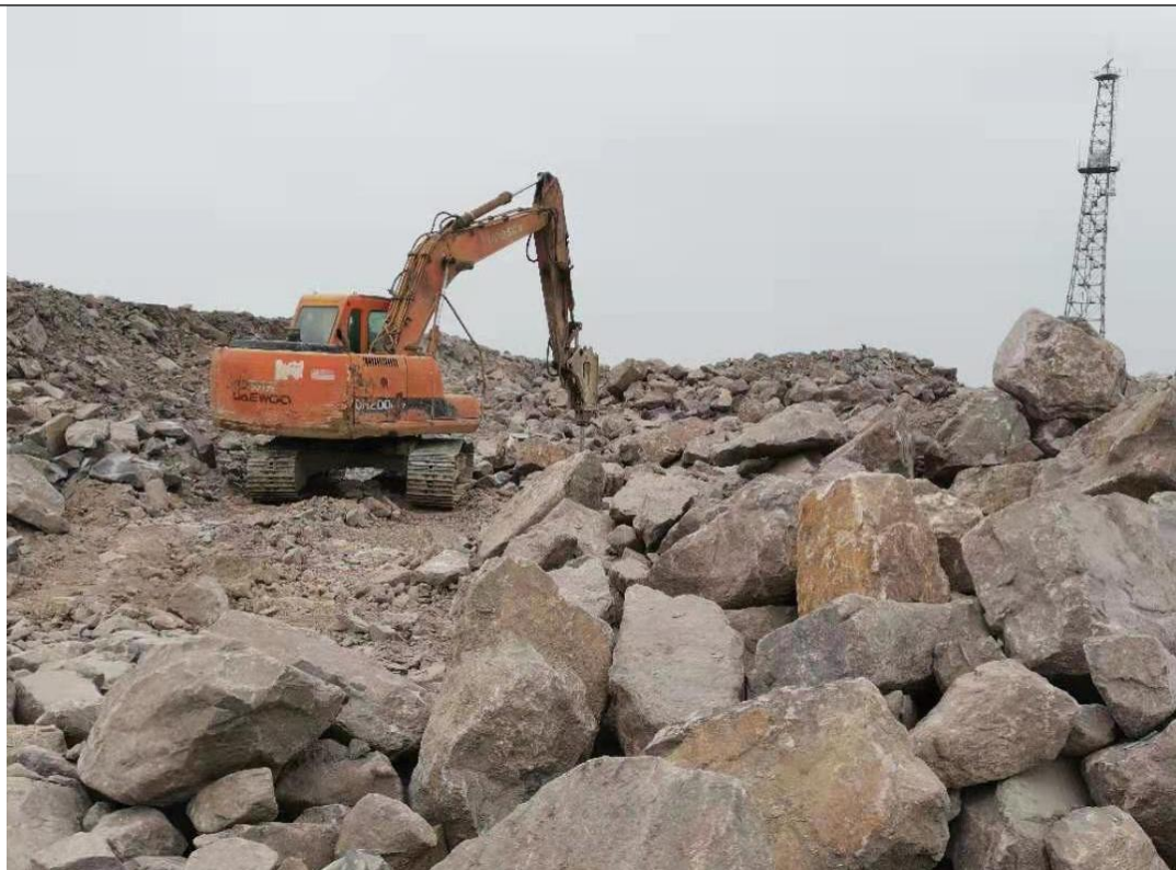
基槽块石破碎
