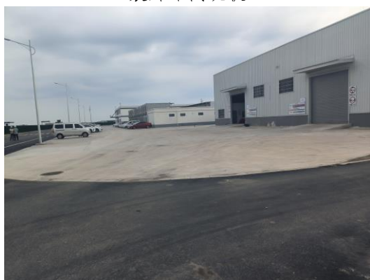
空压站附近现状
