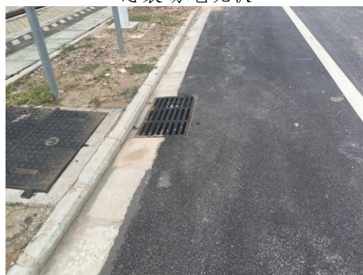
项目在道路一侧布设雨水排水管
