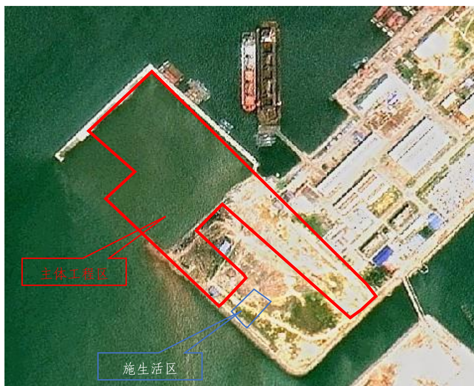
项目建设期间用地卫星拍摄影像图（2022 年 9 月 2 日拍摄）
