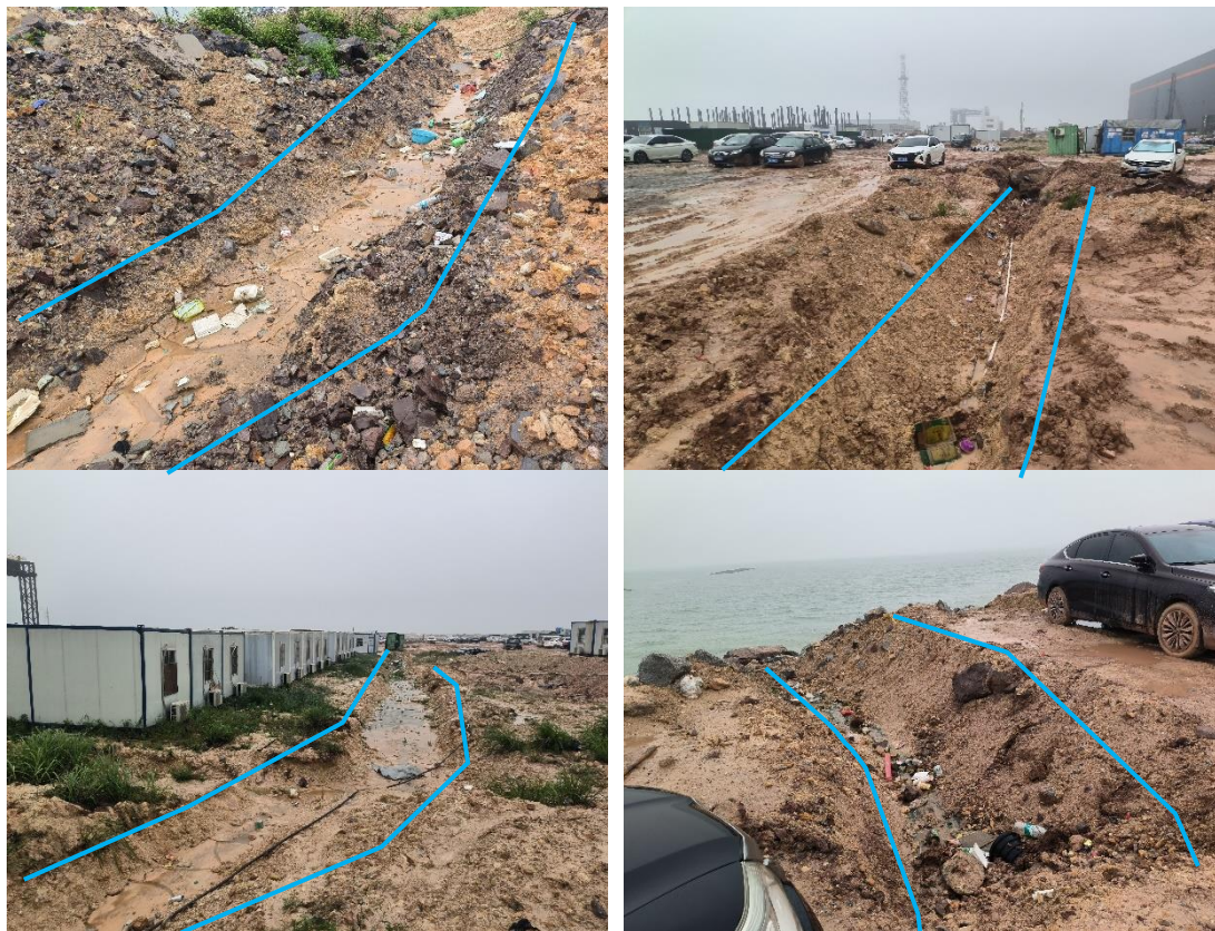
2022 年 11 月~2023 年 4 月，陆续在主体工程区内开挖临时排水沟，排水最终排入周边海域
