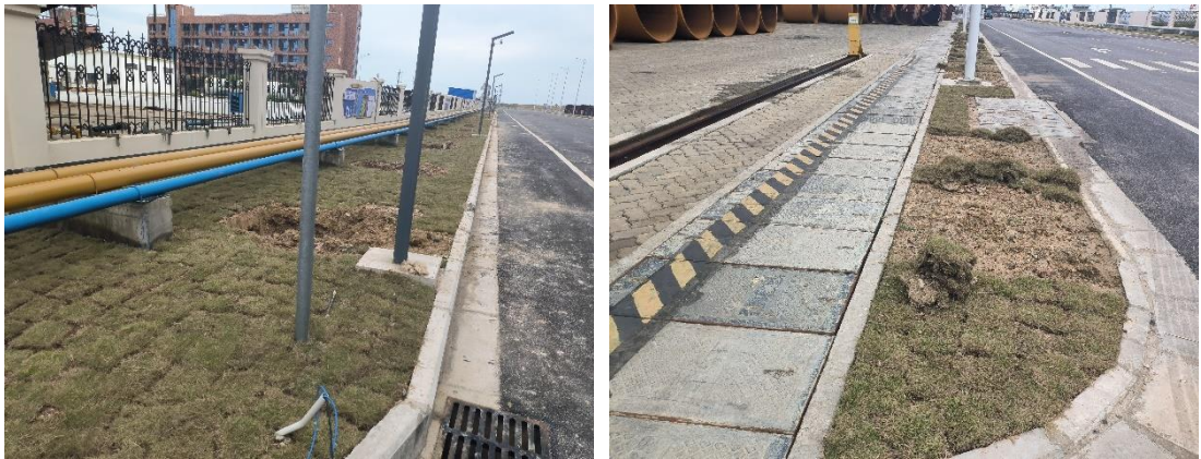
2023 年 10 月，在围墙内侧，道路两侧采取景观绿化措施，主要为铺草皮及栽种乔木
