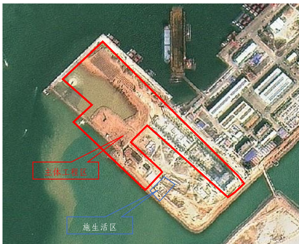
项目建设期间用地卫星拍摄影像图（2022 年 12 月 12 日拍摄）
