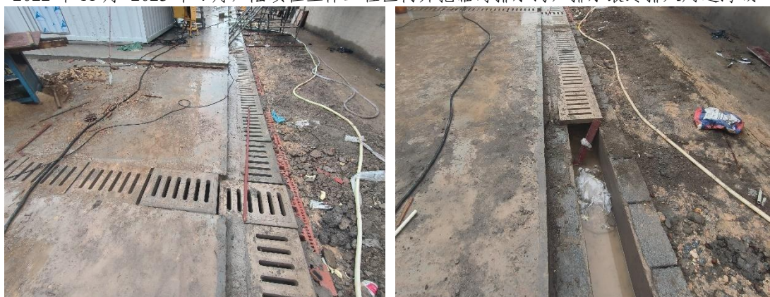
2023 年 1 月~2023 年 3 月，施工生活区四周布设砖砌临时排水沟（排水沟尺寸为 0.3 \times 0.3\text{m} ）
