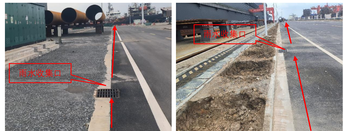
2023 年 9 月~2023 年 10 月，在道路一侧及建筑周边埋设雨水管，并在雨水管中部布设有雨水收集口。
