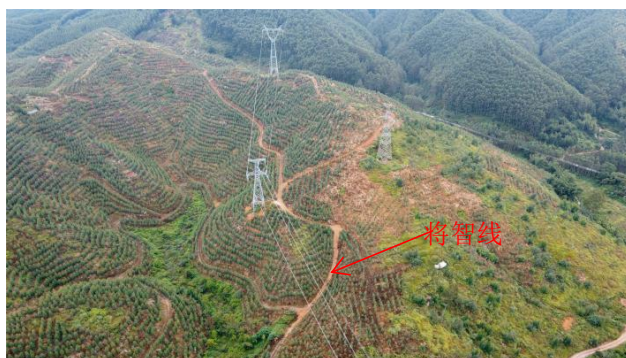
将智线钻越 220kV 邕芦 II 线处
