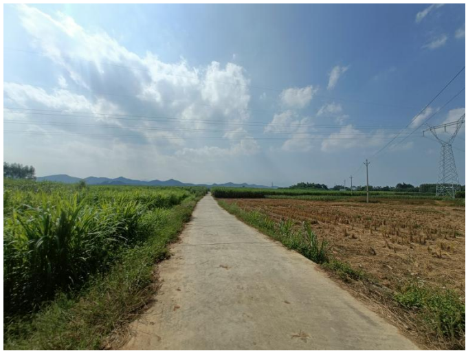
监测断面现状
