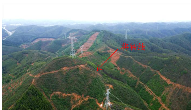
将智线钻越 ±800kV 普侨线
