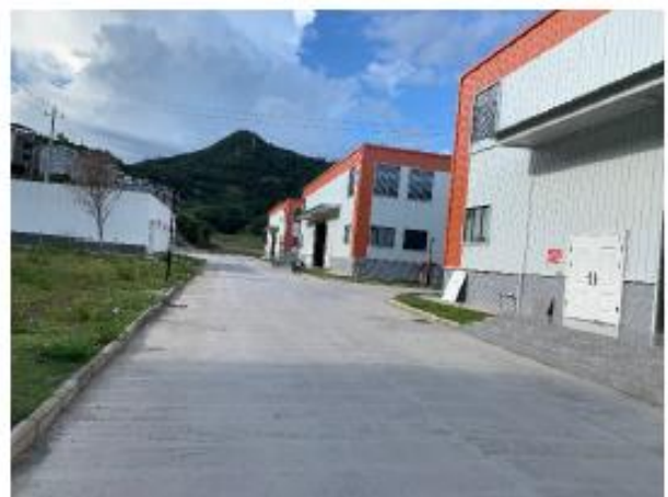
项目厂址西面
