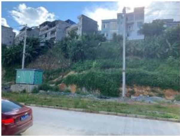
项目厂址西面
