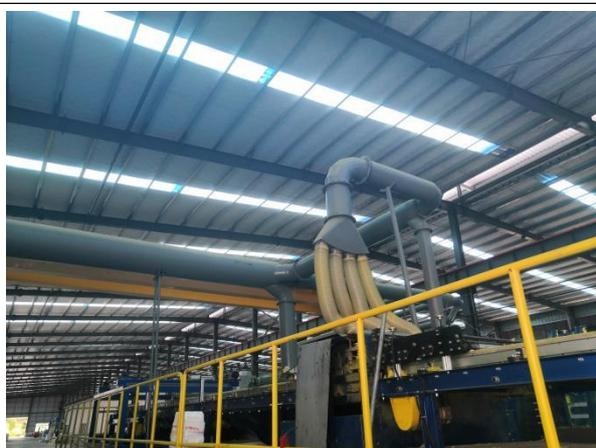
玻璃丝绵切割工序集气罩
