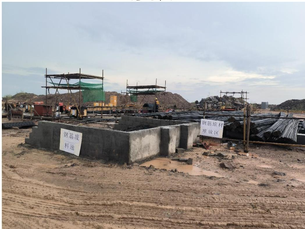
2022年第四季度，施工生产区主要布设在装焊车间附近（位于项目红线内），主要用钢筋加工以及堆堆放。
