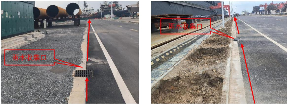
2023年9月~2023年10月，在道路一侧及建筑周边埋设雨水管，并在雨水管中部布设有雨水收集口。
